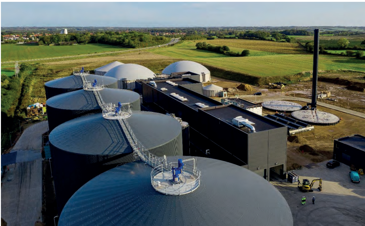
FOTO: BIOGASANLÆG I GLANSAGER VED SØNDEÅRBORG – FRA NATURE ENERGY
